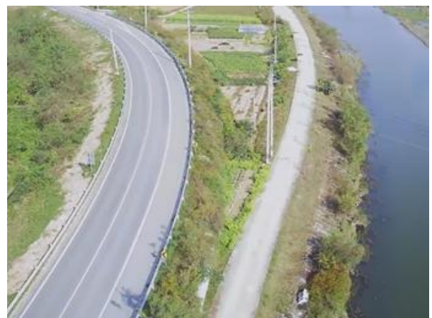
상부 성토부 전경
