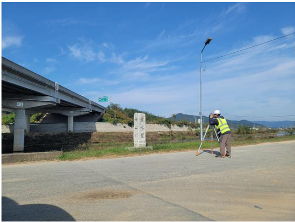
광파기를 이용한 측량 작업사진
